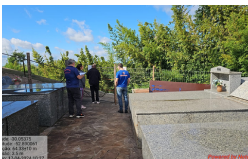
Deslizamento de terra Cemitério,
