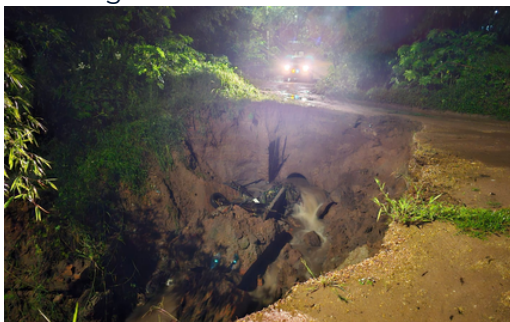
Residência levada por solapamento de margem
