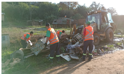
Limpeza de áreas afetadas por inundação
