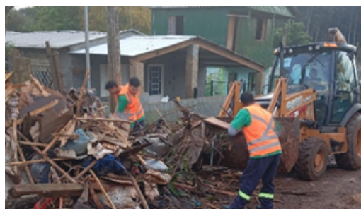
Limpeza de áreas afetadas por inundação
