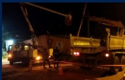
**Dia 18 - Retirada de poste de rede de telefonia com risco de queda sobre residência**
