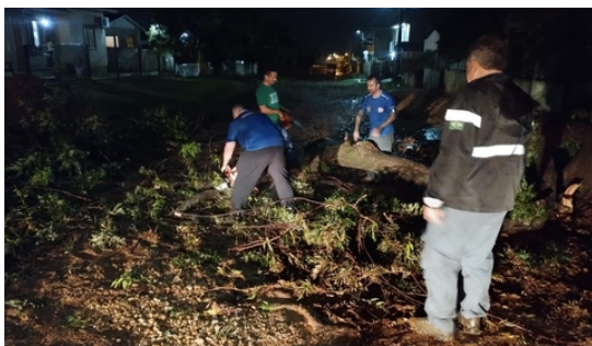
Corte de árvores em situação de risco
