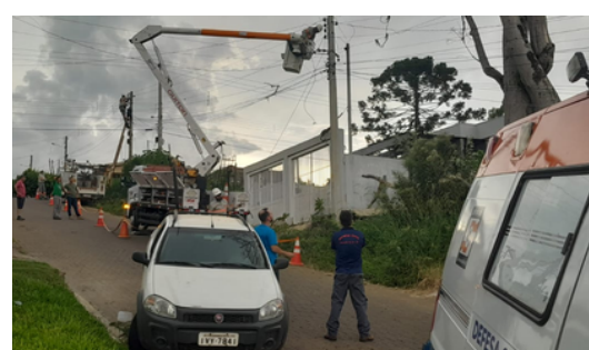
Recuperação de rede elétrica afetada por queda de galhos
