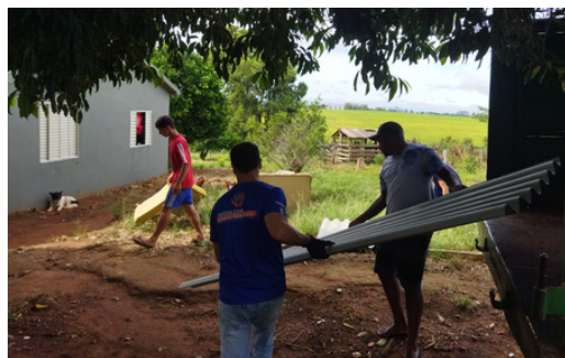
Entrega de telha para reconstrução de moradias
