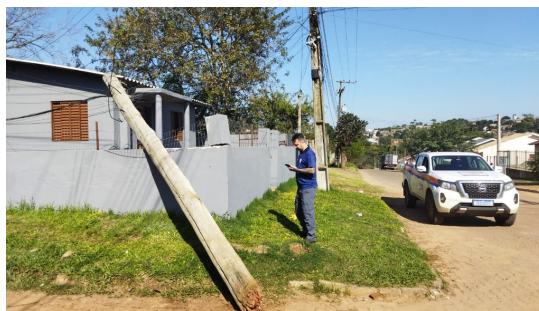
Acidente com poste caído sobre residência
